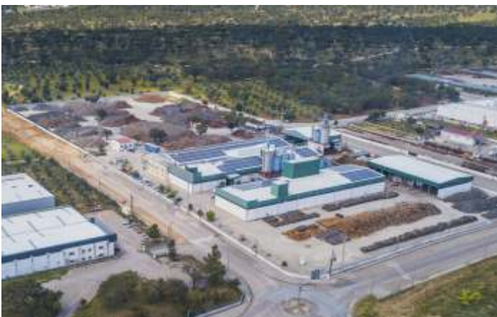
Sedacor III Ponte de Sôr Portugal
